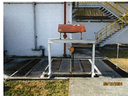
ภาพที่ 2.2-46 ประตูสำหรับปิดกั้น กรณีเกิดเหตุฉุกเฉิน
