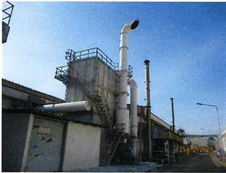
ภาพที่ 2.2-1 ระบบดักฝุ่นแบบถุงกรอง (Bag Filter)
