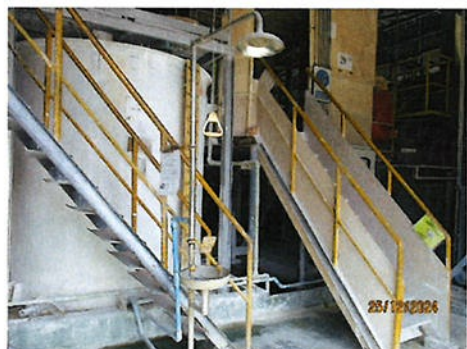
ภาพที่ 2.2-35 อ่างล้างตาและฝักบัวฉุกเฉิน
