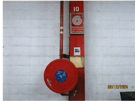
ภาพที่ 2.2-48 (ต่อ) อุปกรณ์ดับเพลิงภายในอาคาร
