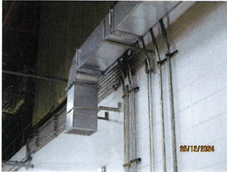
ภาพที่ 2.2-39 ระบบทำความเย็น เพื่อควบคุมอุณหภูมิในบริเวณพื้นที่ทำงาน
