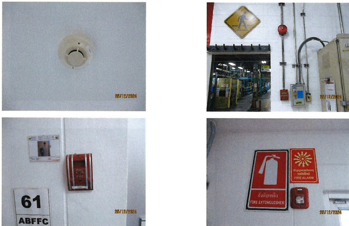
ภาพที่ 2.2-47 ระบบสัญญาณเตือนภัย
