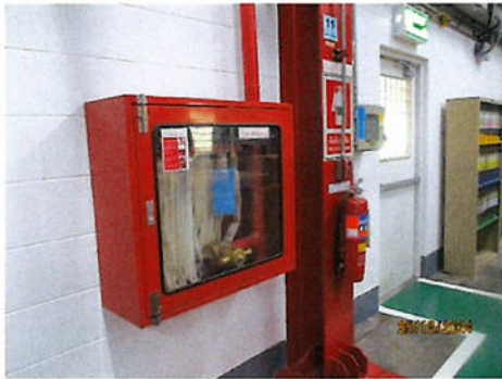
ภาพที่ 2.2-48 (ต่อ) อุปกรณ์ดับเพลิงภายในอาคาร
